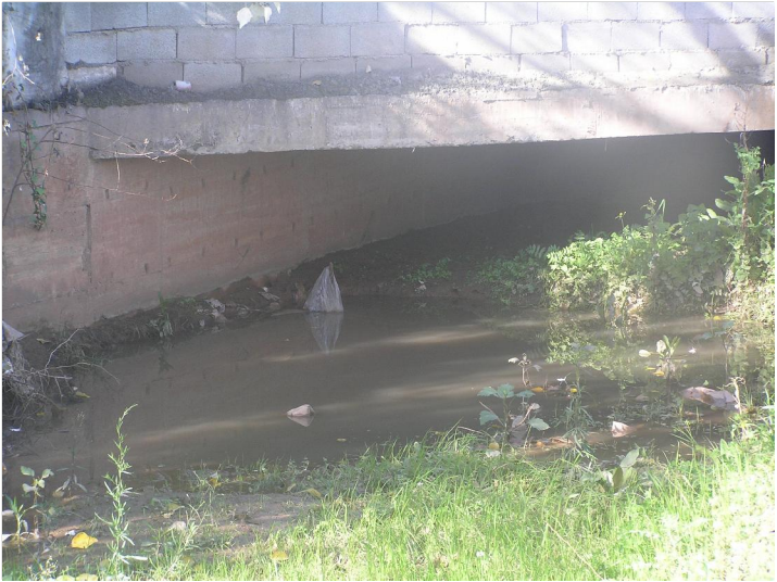
F2 Obra de drenaje transversal aguas abajo
