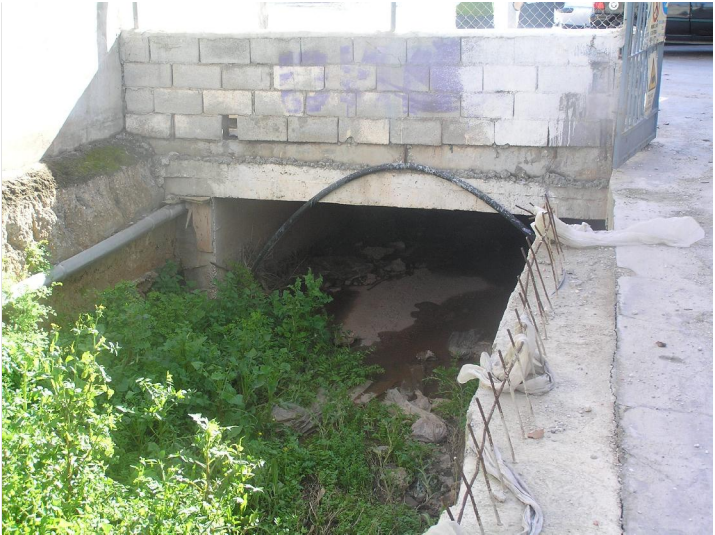
F4 Obra de drenaje transversal aguas arriba
