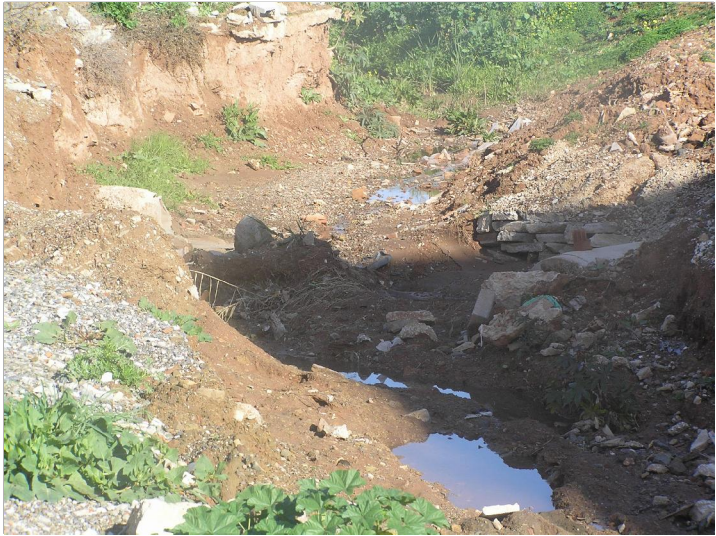
F1 Sección cauce aguas abajo
